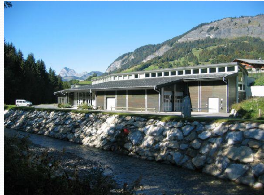
Station d'épuration de la Rosière (source: Mairie de Praz-sur-Arly)
