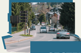
SECTEUR RD1212 Poursuite reprise réseaux et réfection
