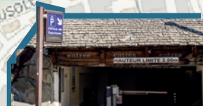
Réhabilitation du PARKING DE L'OFFICE DE TOURISME
