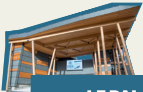
LE PALAIS Restructuration phase 2
