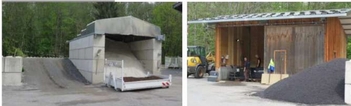
Abri à sel et cuve à saumure :
