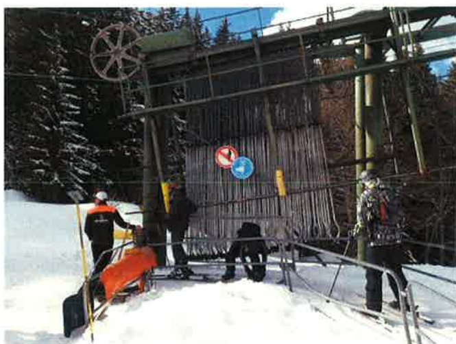
Départ du TK des « Lanchettes » très ancien et difficile, est prévu d'être remplacé (photo CE)
