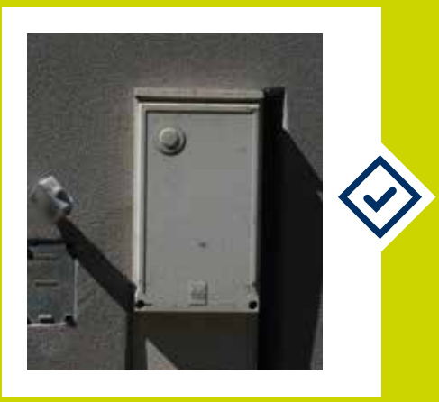
Climatiseur en saillie par rapport au mur
